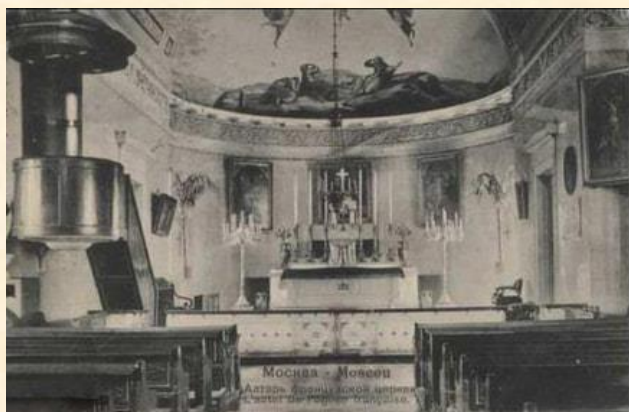
Foto d'archivio (1905). Interno della chiesa.
